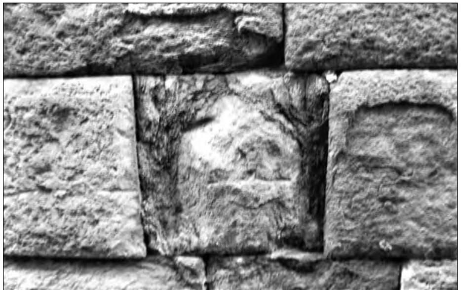
Bild 6: Ein mit weichem Material ausgebessertes Teil. Das zeigt definitiv, dass Mörtel oder Beton bekannt gewesen sein musste.
